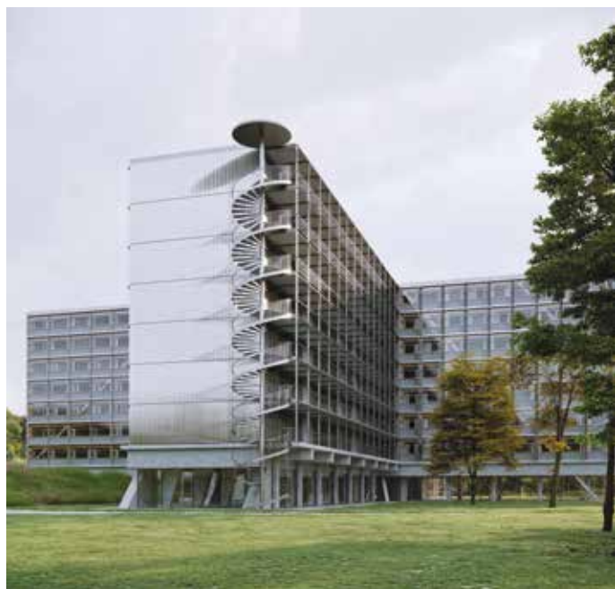
Vue sur le futur Campus Santé, bâtiment en forme de croix.
